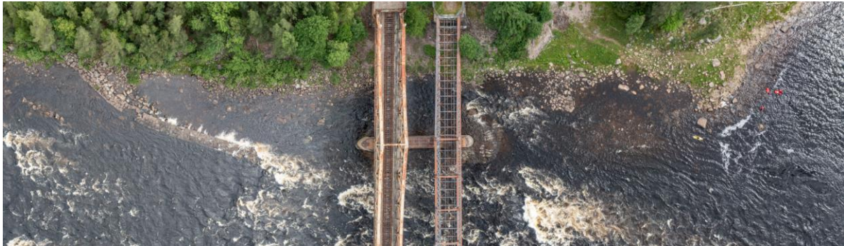
Drönarfoto Edängforsens nedre vänstra del. Där ledarmen ses tydligt uppströms om de två gamla järnvägsbroarna.
